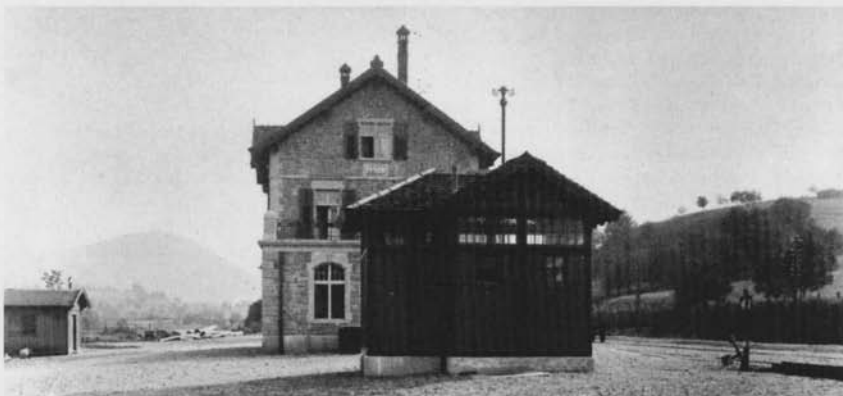
Bahnhof Frick um 1910 mit dem stattlichen SBB-Aufnahmegebäude. Das Abortgebäude im Vordergrund wäre zugunsten des Aufnahmegebäudes der Frick-Kienberg-Bahn ersetzt worden. Foto: Archiv SBB Historic
